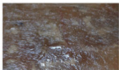
Strutturazione ancora fresca con resina poliestere e Mat.
