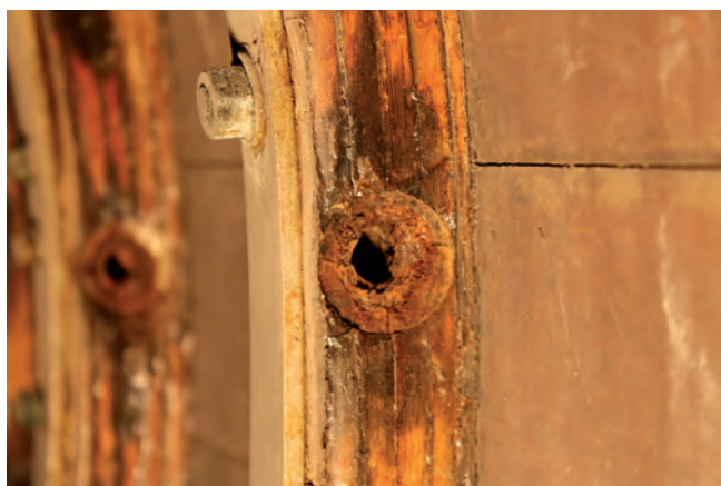
Figura 2 Il foro di un perno metallico corrosivo, esempio di interazione dannosa tra metallo e strutture lignee.
