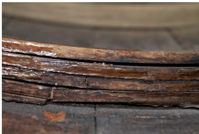
Figura 3 Fenomeni di delaminazione di un'ordinata lamellare.
